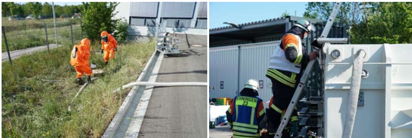
links: Das Löschmittelgemisch wurde zunächst im unterirdischen baulichen Fünf-Kubikmeter-Auffangbehälter aufgefangen ... rechts: ...und anschließend in den flüssigkeitsdichten Abrollbehälter des Unternehmens umgepumpt (hier bei der Vorbereitung der Umpumparbeiten).
