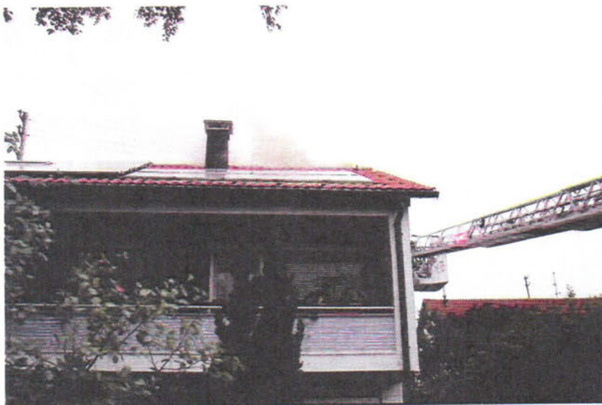
Ansicht des Brandobjektes von der Straßenseite aus. Auf dem Dach sind Photovoltaik- sowie Solarthermiemodule zu erkennen.
